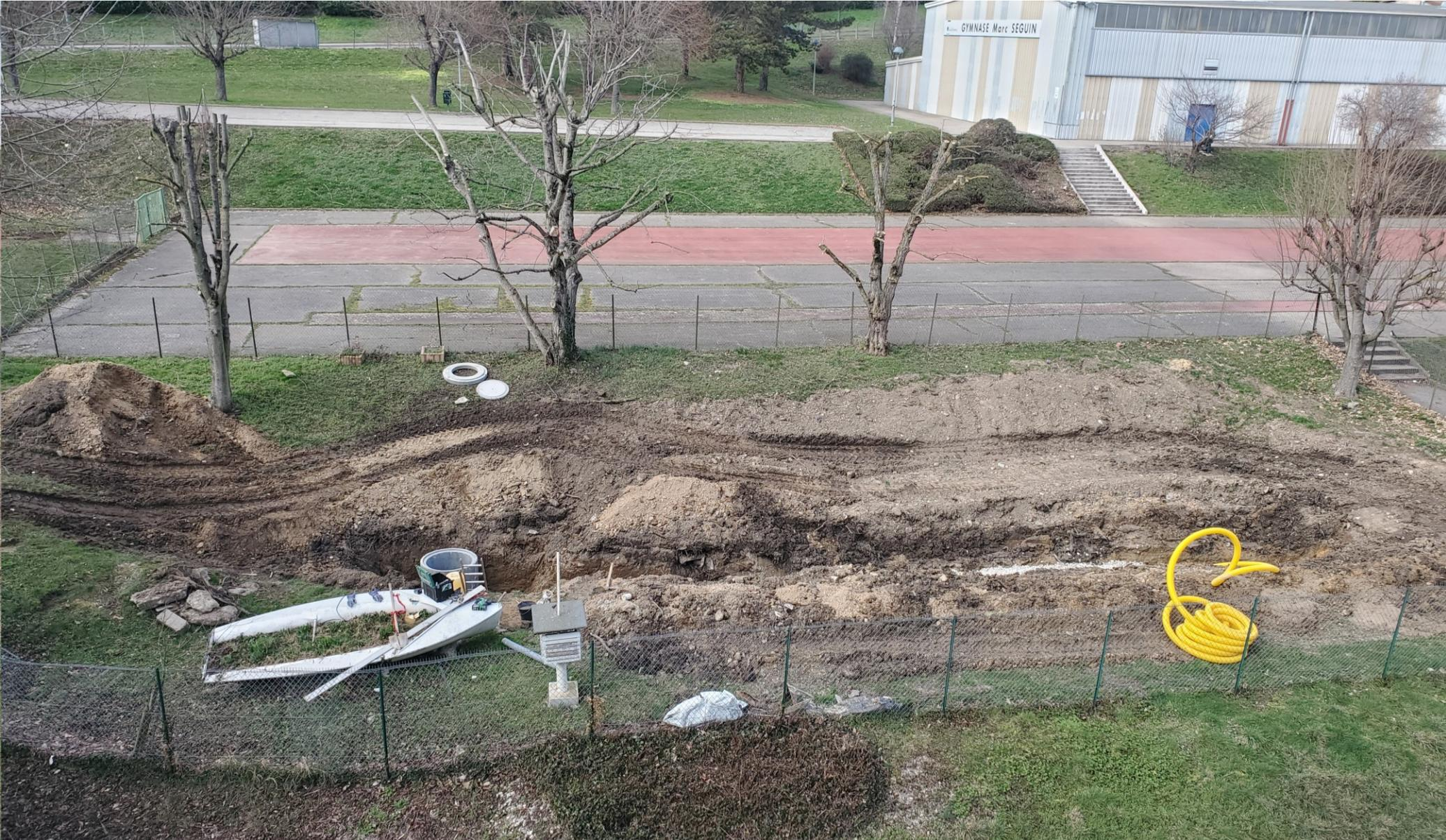
*16 février 2024 : mise en place des 10 tonnes de galets et du drain (en jaune) qui est directement relié au puit.*
