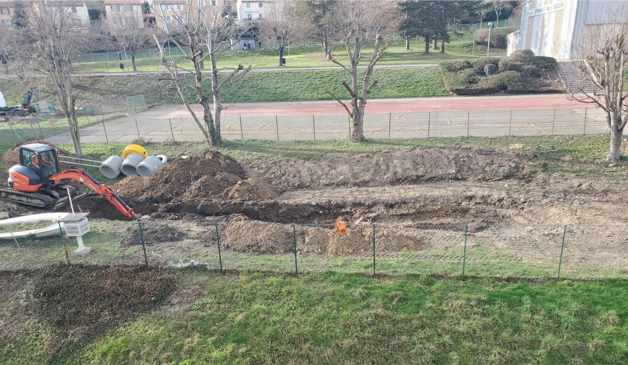
*15 février 2024 : 03 sources de surfaces existent, une réserve d'eau avec drain est créée sous la future mare.*
