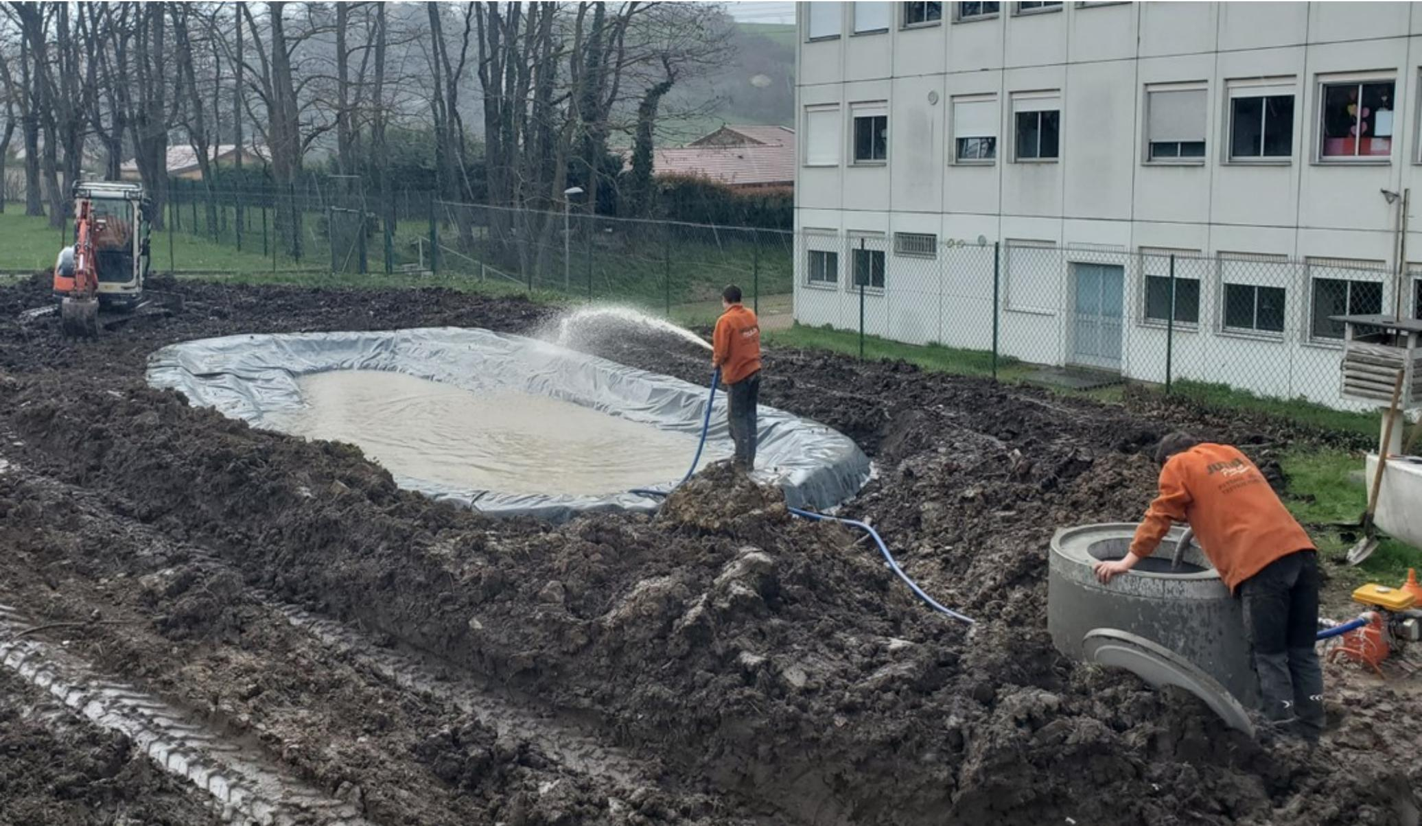
*22 mars 2024 : l'eau stockée dans le puit est utilisée pour finir le remplissage de la mare.*
