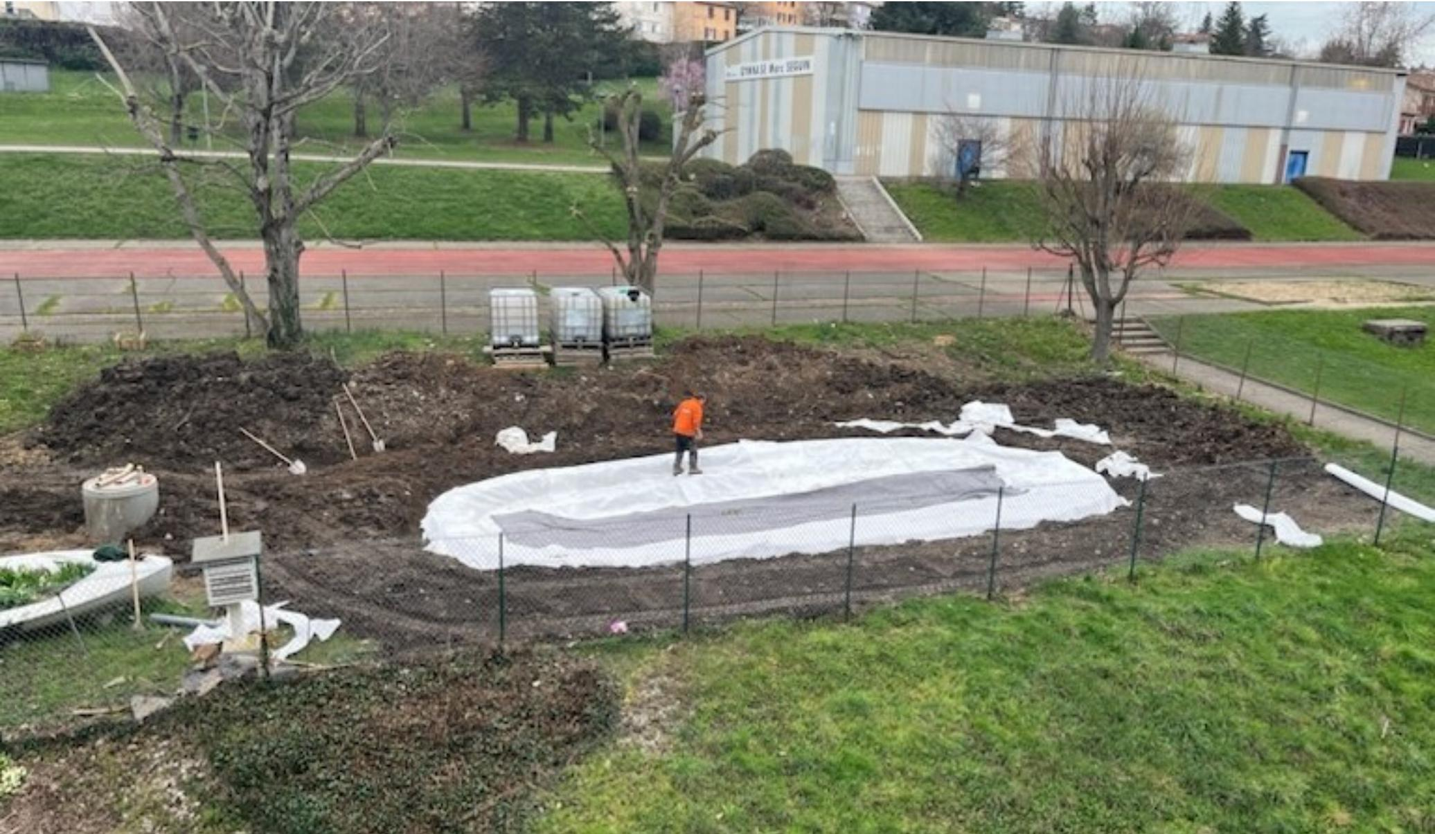
*22 mars 2024 : mise en place du géotextile et de la feutrine.*
